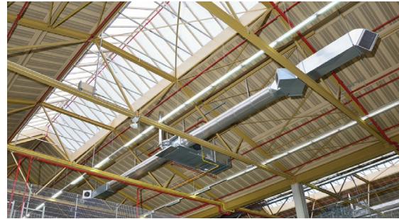
Abbildung 13: Warmlufterzeuger mit Thermovent-Mischluftverteilern zur aktiven Beimischung von Raumluft in den Ausblasstrahl
