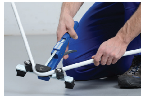
Bild 11: Durch enge Rohrbögen lassen sich Fittings einsparen und Druckverluste im Leitungssystem reduzieren
