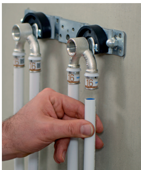
Bild 8: Für Ringleitungen unverzichtbar: U-Wandscheiben für den doppelseitigen Anschluss
