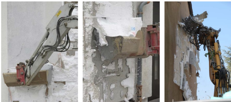
Abbildung 7: Selektives Abschälen der einzelnen Lagen eines WDVS. Oberputz (links), Dämmstoff (Mitte) und teilselektives Abschälen in der Praxis (rechts) 141
