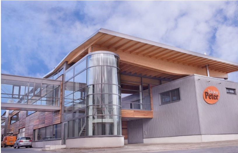
Abbildung 6: Die vollständig demontierbare und recycelbare Backstube Peter in Essen 106
