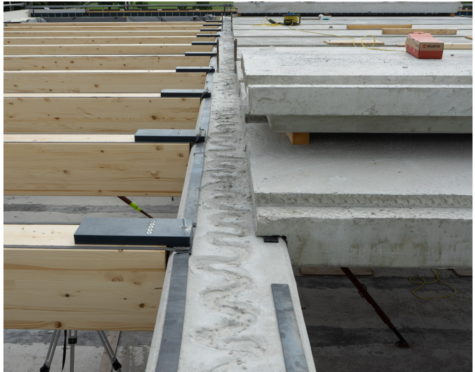
Baustelle des Neubaus der shopware AG (Bild: © Brüninghoff)
