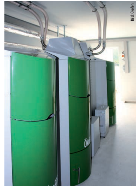
Neben speziell angefertigten Großanlagen ist das häufig verwendete Konzept, mehrere Kessel zu einer Anlage parallel bzw. nacheinander zu schalten.
