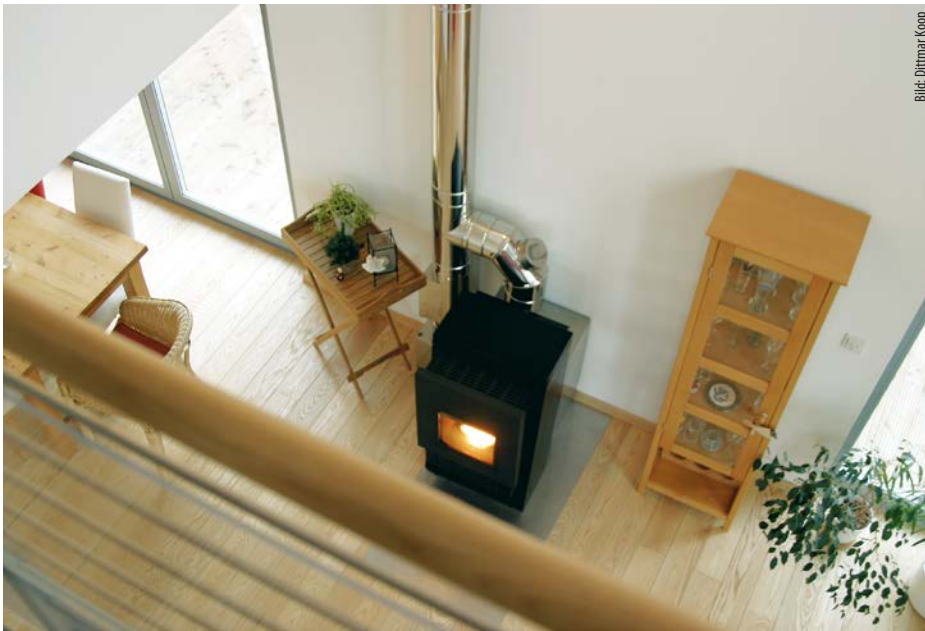
Pelletöfen liegen im Leistungsbereich bis etwa 15 kW. Sie werden im Wohnraum aufgestellt und wurden von der brancheninternen Statistik lange Zeit überhaupt nicht wahrgenommen.
