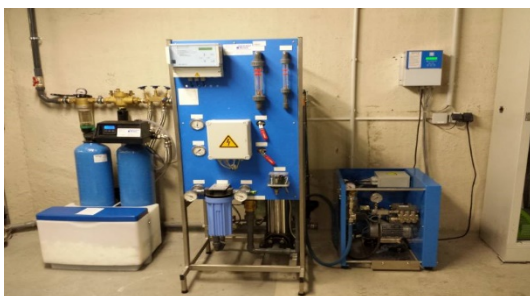
Abb. 33: Wasserenthärtung Umkehrosmose (Entsalzung) Hochdruckbefeuchter-Pumpenstation
