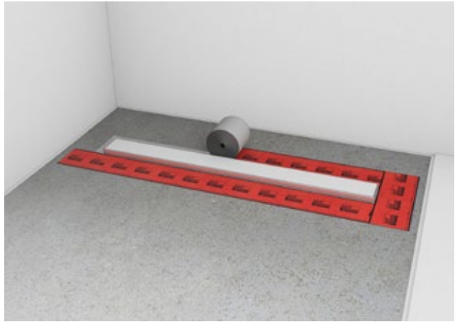
Schritt 3: Das Seal System Dichtband wird überlappend mit dem Flansch der Duschrinne und dem Estrich verklebt.
