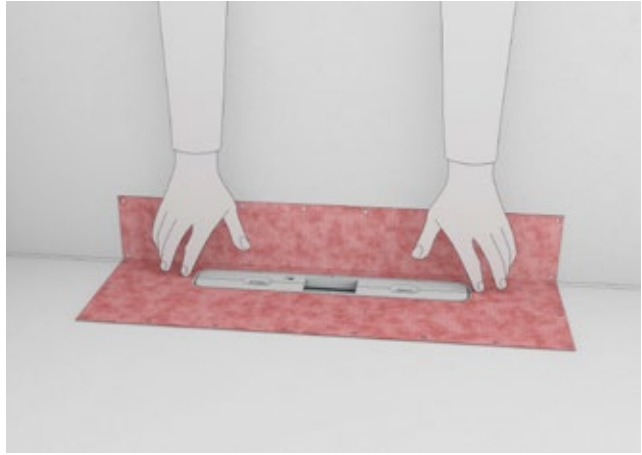
Schritt 4: Dicht auf Klick: Ist der Estrich eingebracht, wird der erste Teil des Rohbauschutzes vom Ablauf entfernt und die mitgelieferte Dichtmanschette per Klick-Mechanismus eingesetzt. Der Duschplatz kann nun abgedichtet und verfließt werden.
